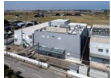
新設した第6製剤棟
