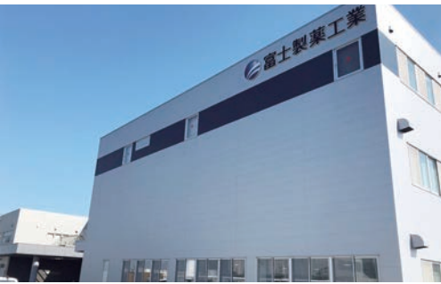
2020年8月に完成した 管理厚生棟
