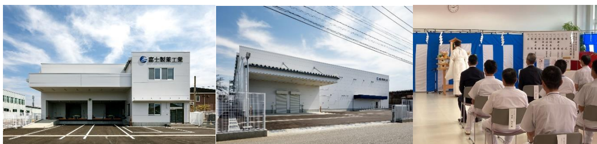
第2物流倉庫棟
